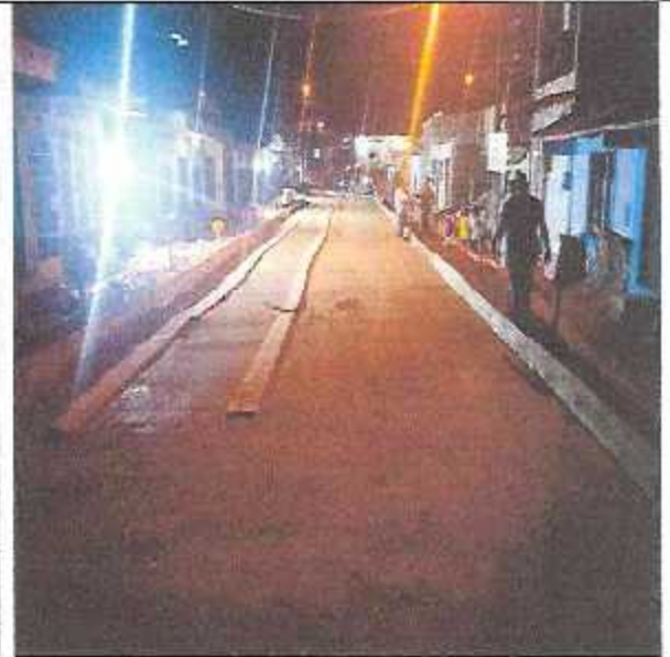
Conformación de sub - base con material A-2-4
