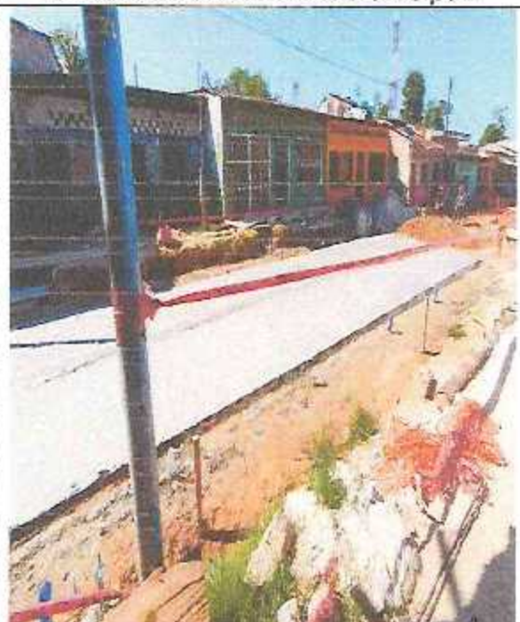
Llenado de solado en calle sr. Sipán.
