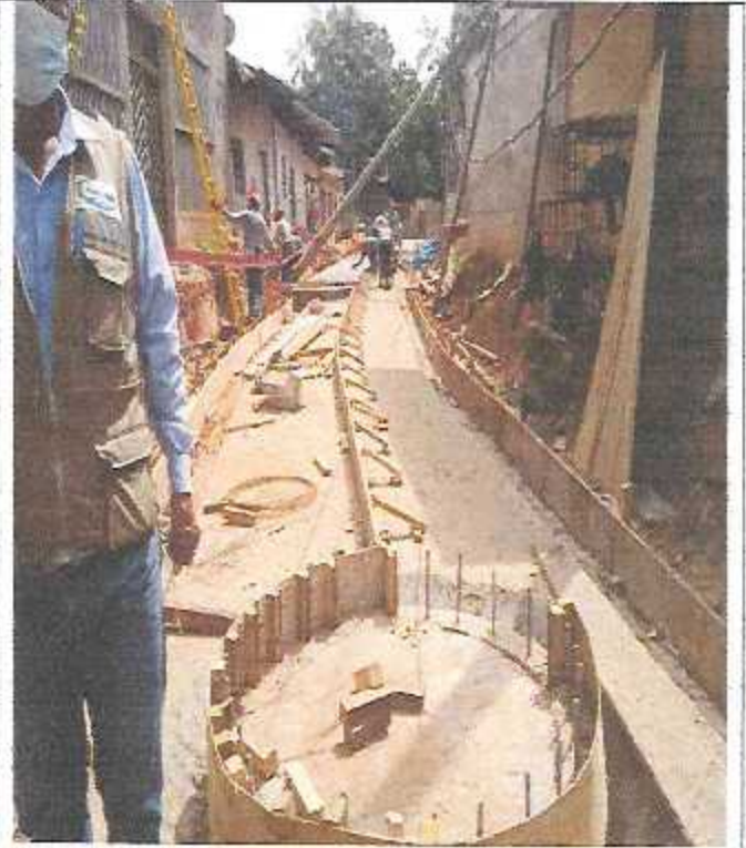
Llenado de mortero para losa en pavimento con f'c=210\text{kg/cm}^2
