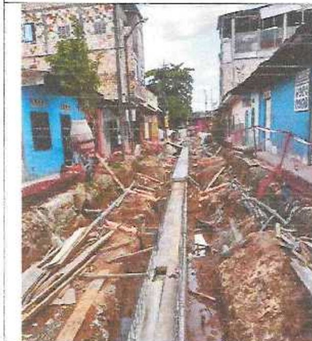
Encofrado de losa superior de canal.
