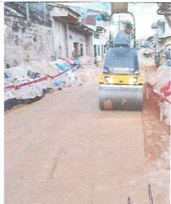
Compactado de sub base
