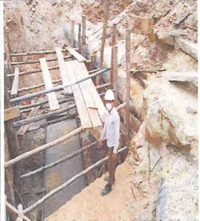
Llenado de solado en calle sr. De Sipan
