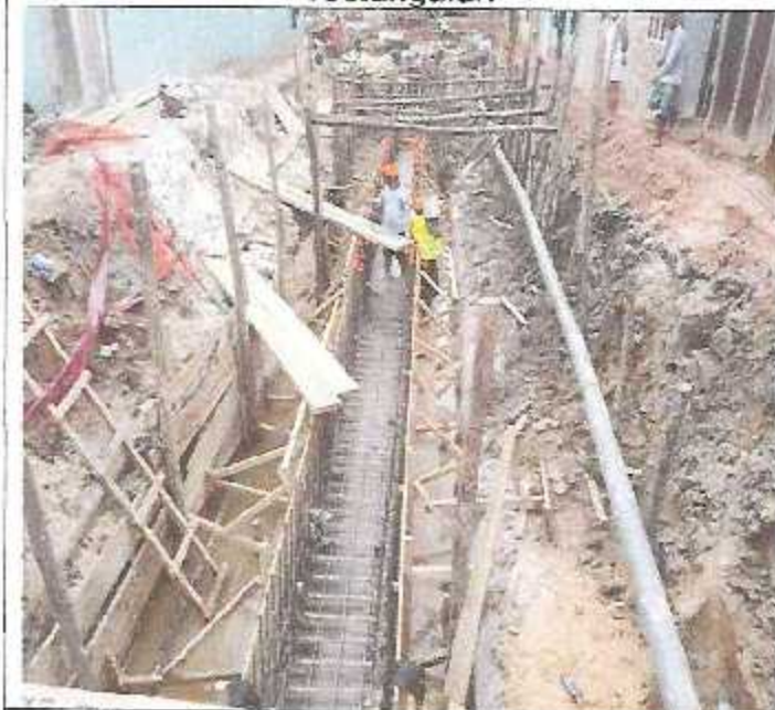
Llenado de mortero en losa de fondo de canales.
