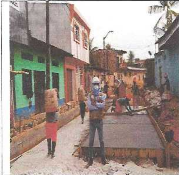
Llenado de mortero en pavimento rígido con f'c=210\text{kg/cm}^2
