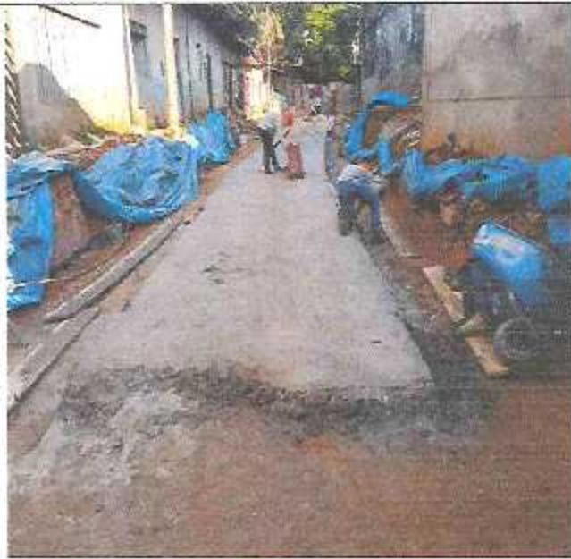
Llenado de base con solado 1.8 c/a en calle proiongación José Gálvez.
