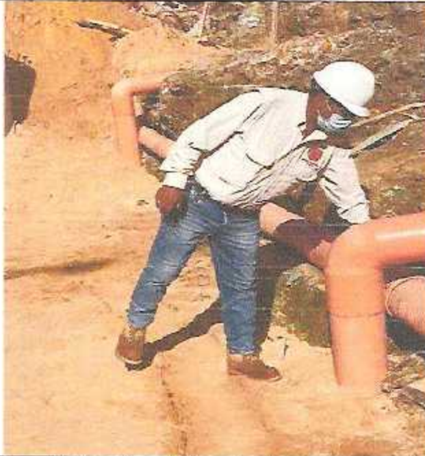
Colocación e instalación de conexiones domiciliarias.
