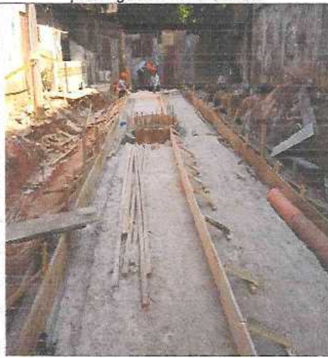
Encofrado para pavimento e=20cm con llenado tipo damero.
