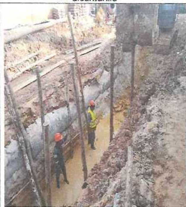
Entibado de zanja de paredes de canal.
