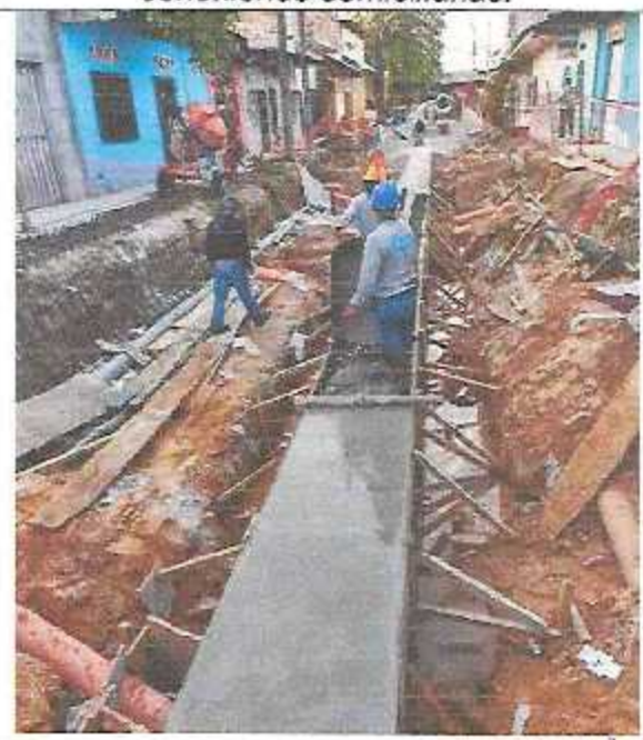
Llenado de mortero para losa superior de canal.
