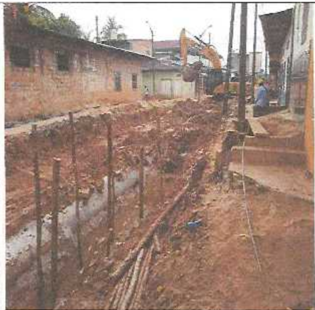
Excavación de zanja hasta fondo de alcantarilla
