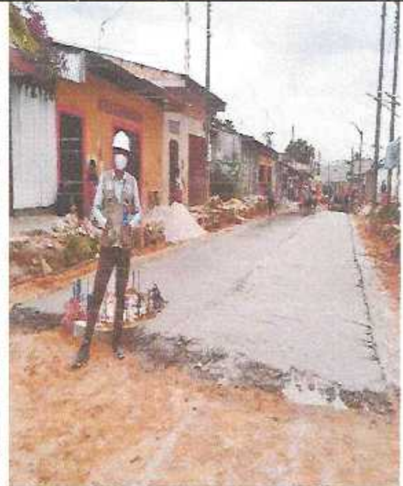
Llenado de solado en calle sr. Sipán.
