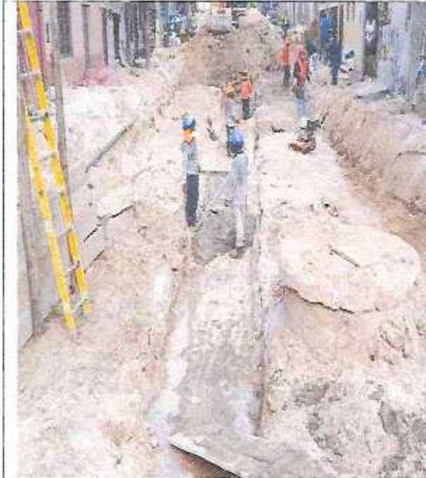
Excavación de zanja canal en calle José Gálvez y llenado de solado.
