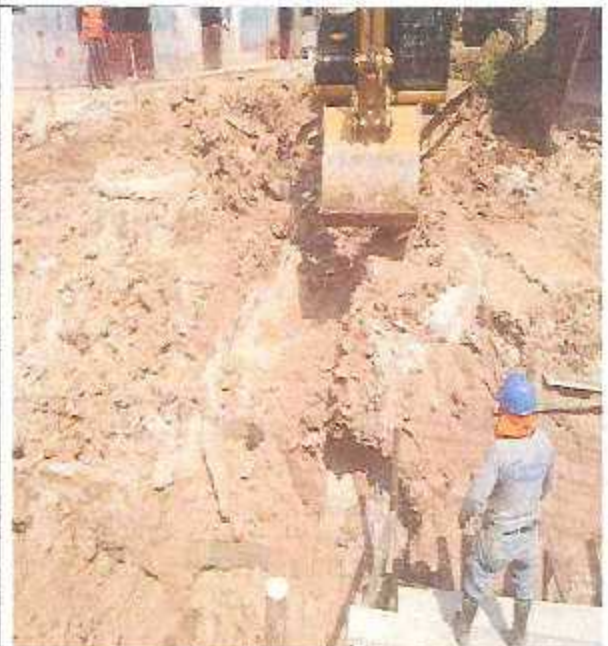
Excavación hasta cota de fondo de canal en pasaje Inti.
