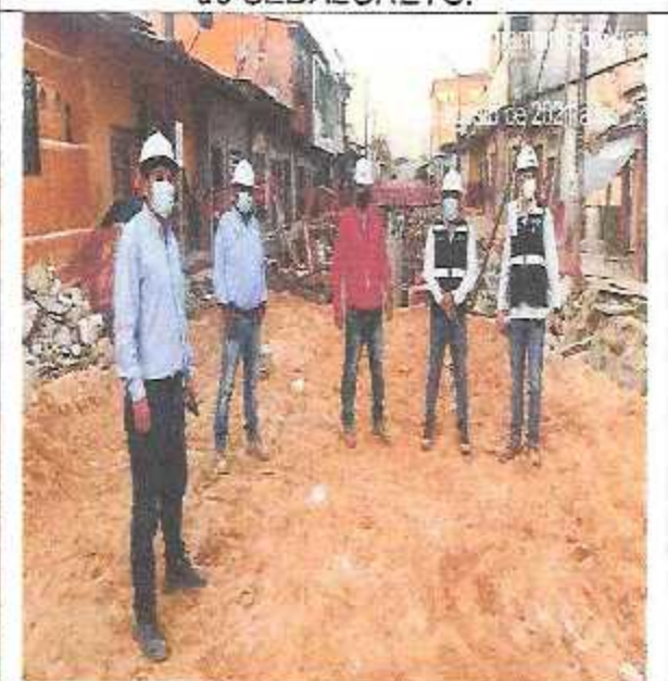
Visita del coordinador del GOREL en obra.
