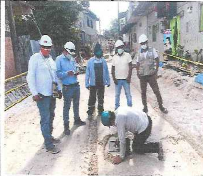
Ensayo de densidad de campo a nivel de sub rasante A-3.
