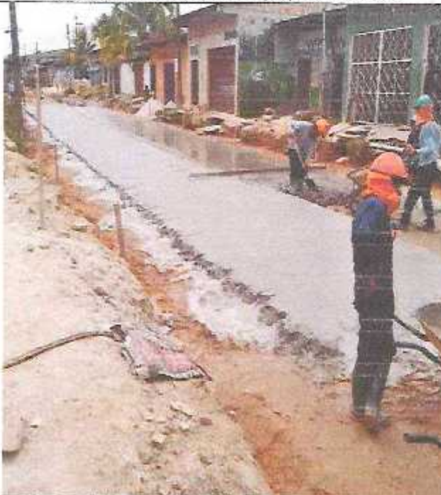
Llenado de solado en calle sr. Sipán.
