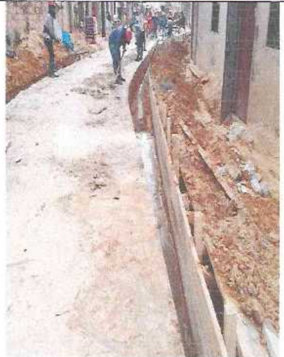
Llenado de losa de rodadura.
