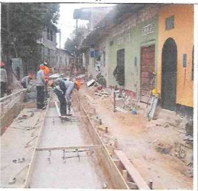
Llenado de mortero para losa en pavimento con f'c=210kg/cm2
