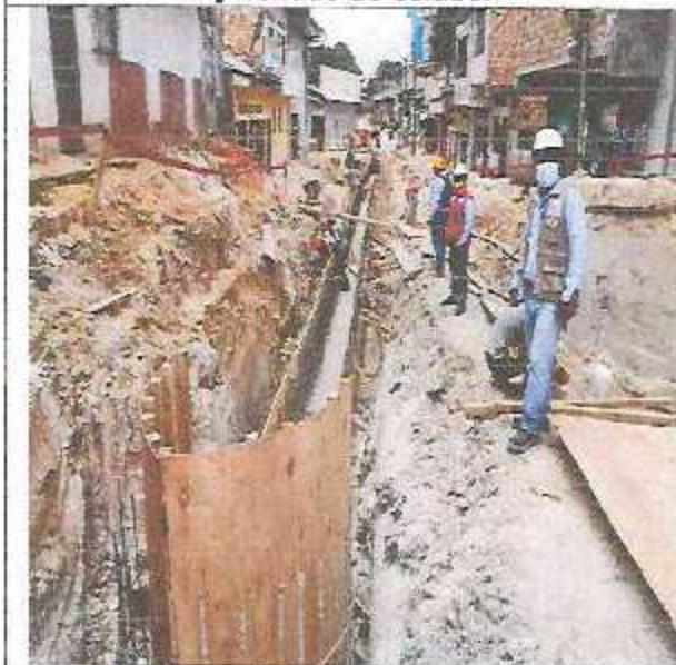
Encofrado de muros de canal y buzón.
