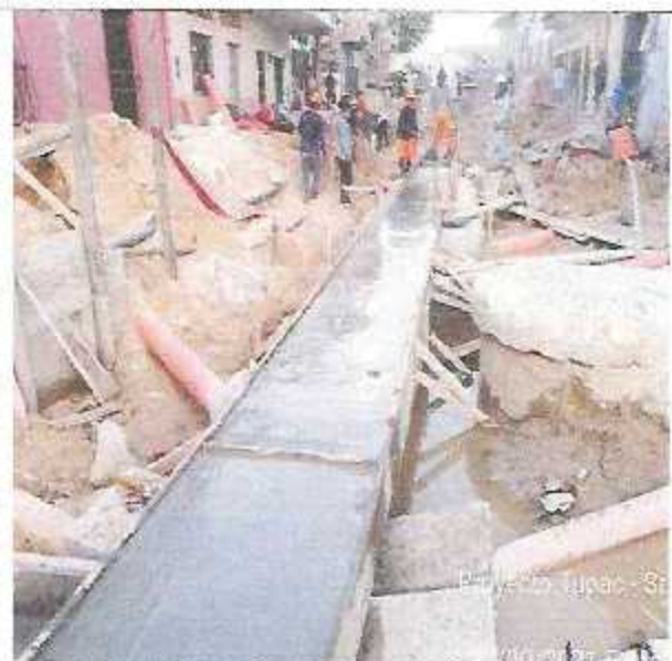
Llenado de losa superior de canal en calle José Gálvez.
