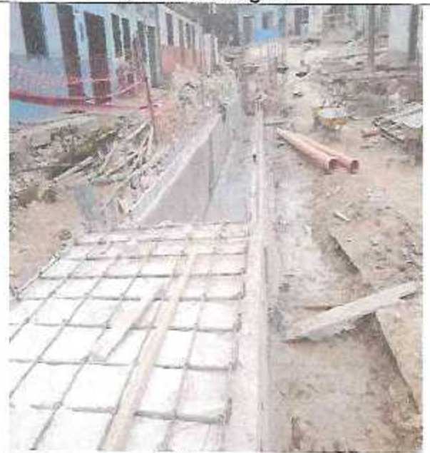
Pulido de paredes de canal.
