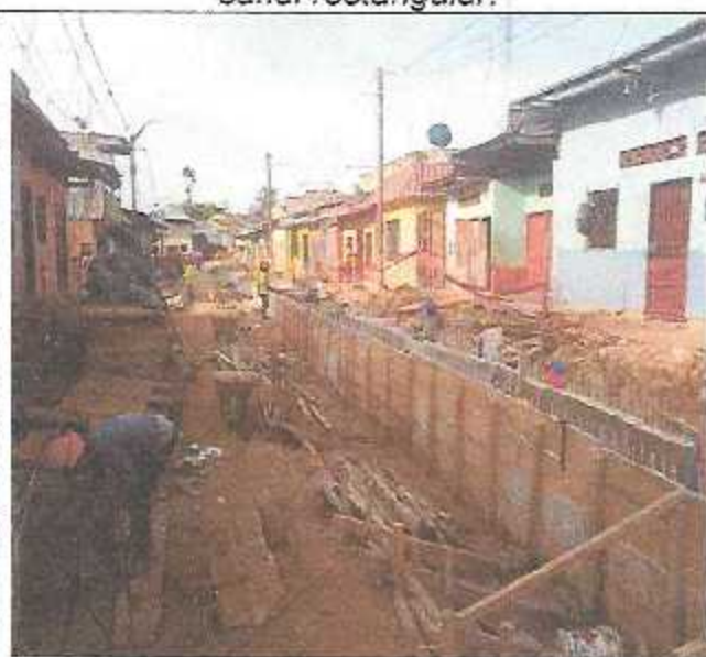
Encofrado y desencofrado de muros y losa de canal.
