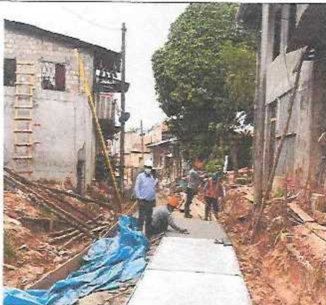
Ensayo de densidad de campo a nivel de sub rasante A-3.
