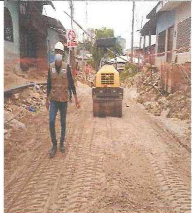
Relleno y compactado a nivel de A-3 en calle Pachacútec.
