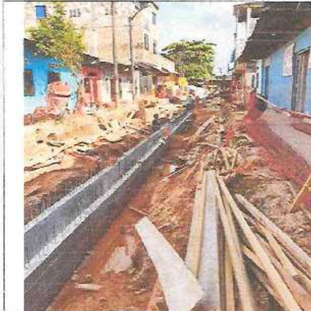
Encofrado y desencofrado de muros para canal.
