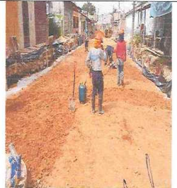
Llenado de losa de rodadura.
