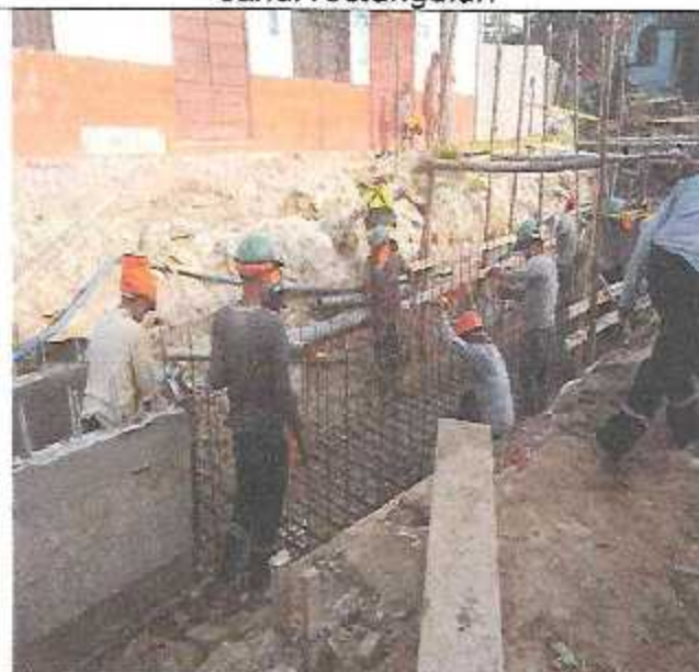
Colocación de acero corrugado para canales.
