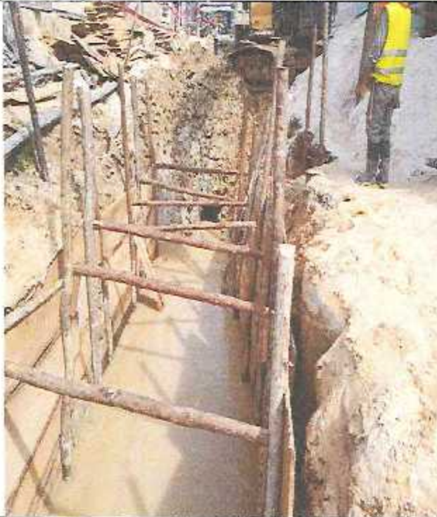
Cama de arena y llenado de solado para canal rectangular.
