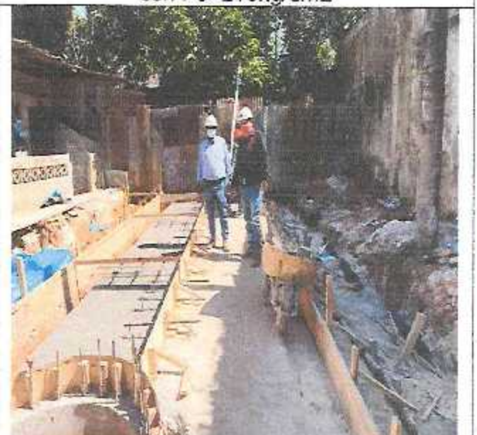
Llenado de mortero para losa en pavimento con f'c=210\text{kg/cm}^2
