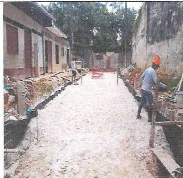
Relleño y compactado a nivel de sub rasante con material A-3.
