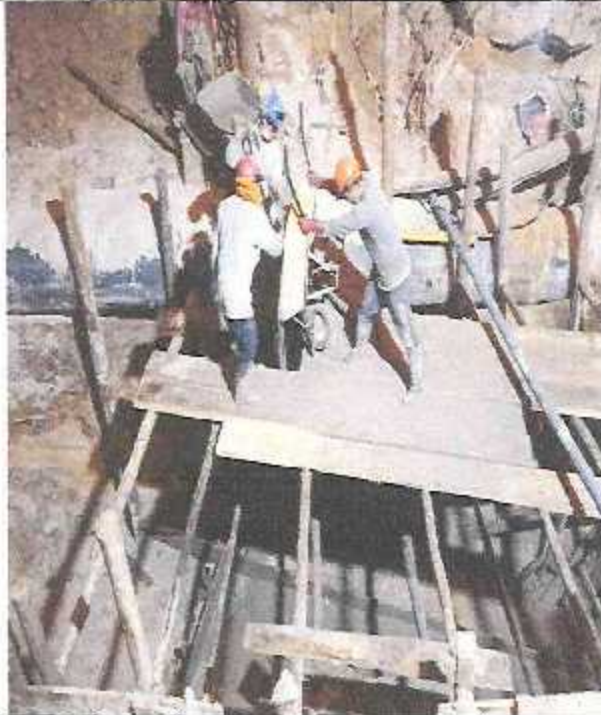
Llenado de solado en calle sr. De Sipan
